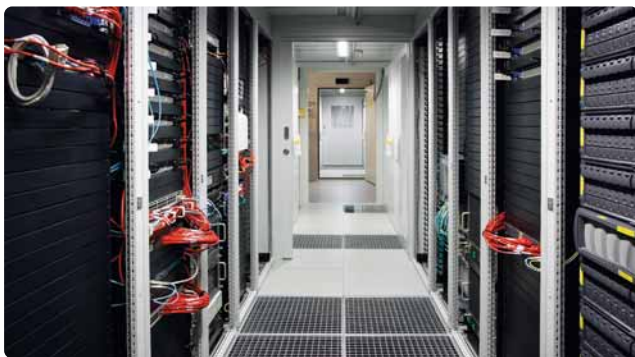
Die Installation von RiMatrix S erfolgt in einer der Büroetagen als Raum-in-Raum-Lösung auf einer Fläche von rund 100 m 2 .
