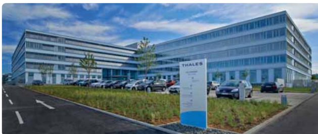
Die neue Unternehmenszentrale von Thales Deutschland in Ditzingen, in der rund 100 Serverracks arbeiten, wurde im Mai 2014 bezogen.
