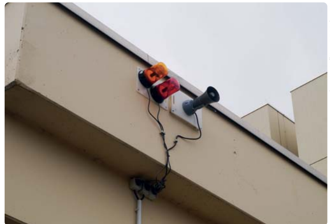
Links: Beispiel für erschütterungsintensive Bauarbeiten (Vibrationsverdichtung), rechts: Abbildung des eingebauten Warnlichts und des Signalhorns.
