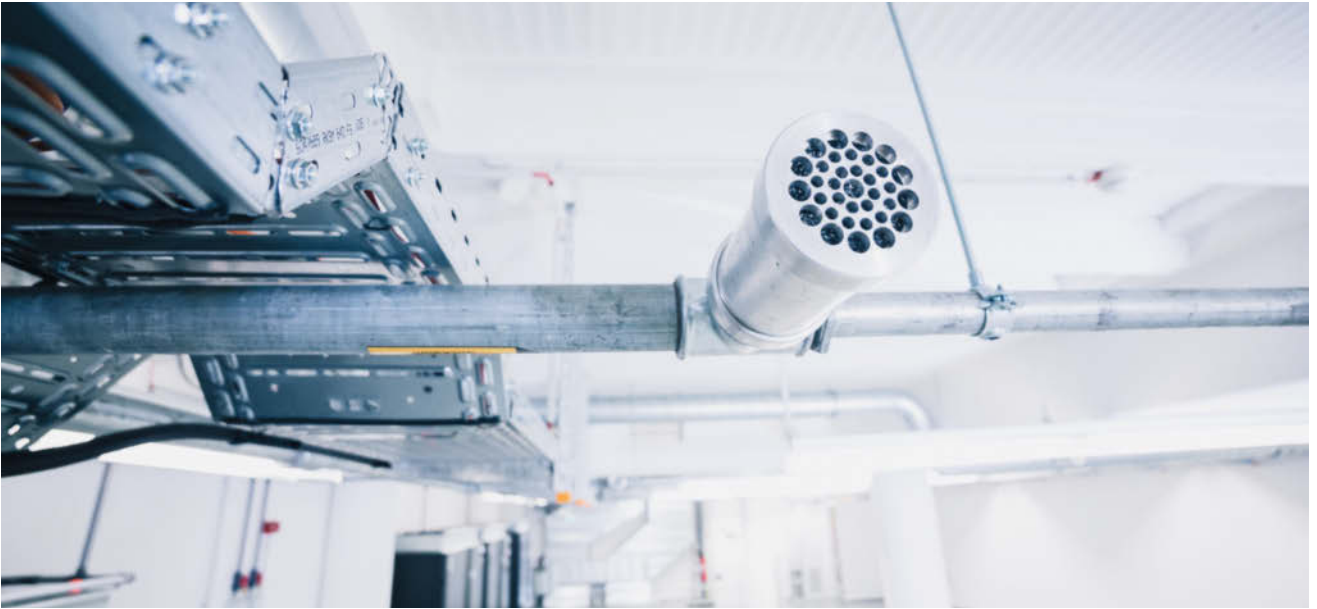
Die Löschdüsen der FirExting-Gaslöschanlage sind mit speziellen, VdS-zugelassenen Schalldämpfern versehen, die den Schalldruck um 20 bis 38 dB(A) reduzieren.
