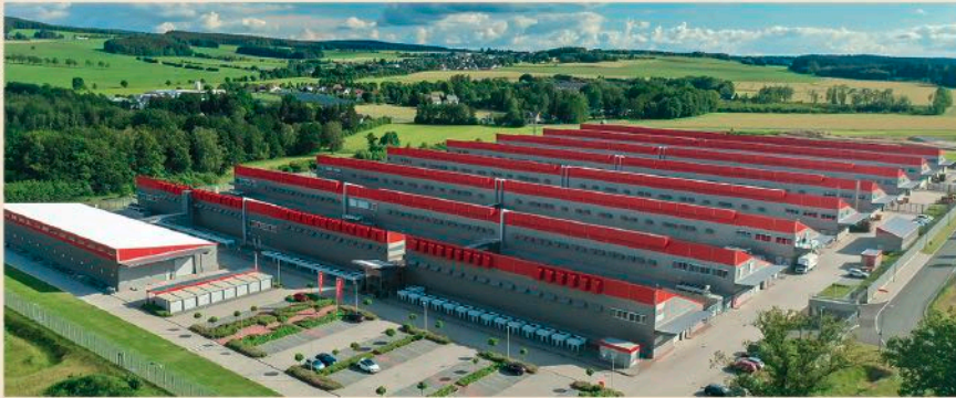
2022 hat Hetzner in Falkenstein bereits die zehnte RZ-Halle fertiggestellt (Abb. 2).
