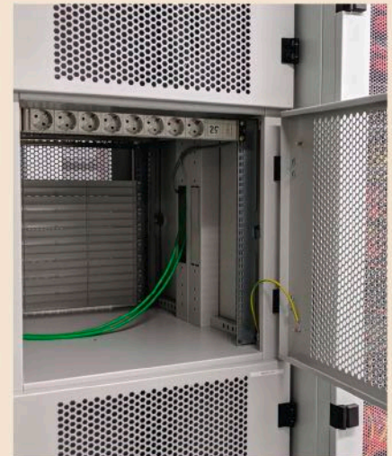
Auch Teile von Racks (hier acht Höheneinheiten) lassen sich separat mit Strom- und Netzwerkanschluss sowie abschließbarer Tür ausstatten (Abb. 10).
