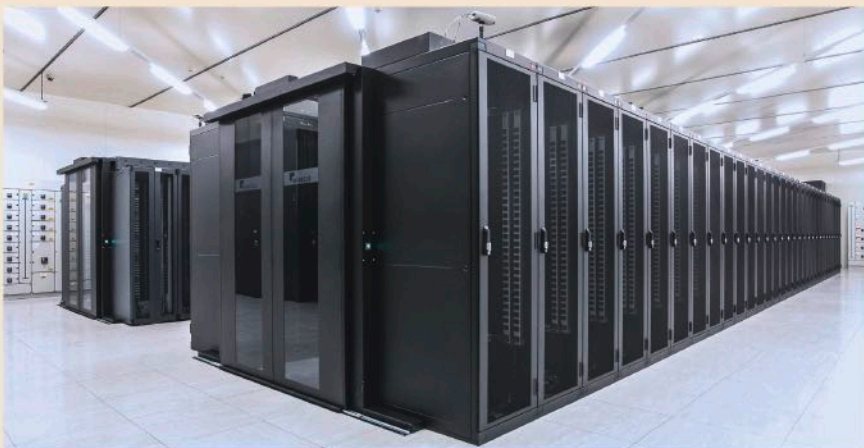
Einhausungen kanalisieren den Luftstrom und ermöglichen so eine effizientere Kühlung (Abb. 8).
