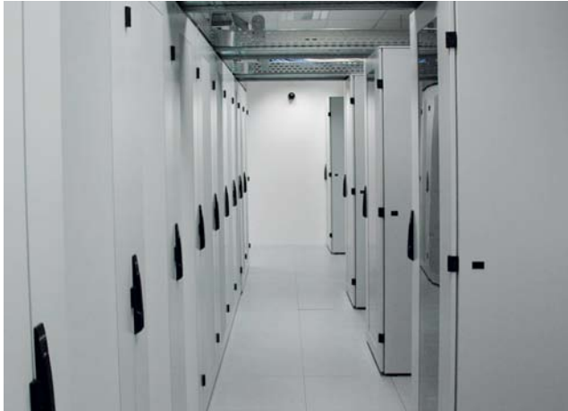
Links eine Reihe Schäfer-Klimaschränke, rechts einzelne nicht klimatisierte Schäfer-Schränke mit Patchfeldern (Abb. 5)
