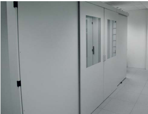
Die Cold-Section-Einhausung mit geschlossenen Türen von außen (Abb. 3)
