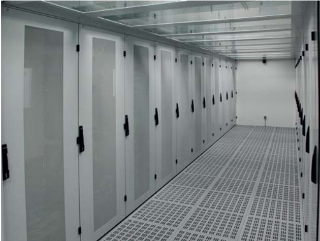
Schäfer-Racks in einer Cold-Section-Einhausung, ebenfalls von Schäfer IT-Systems (Abb. 2).
