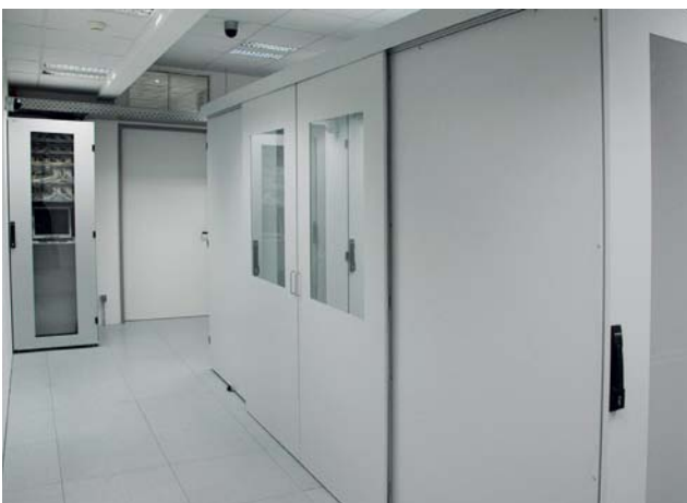
Die Cold-Section-Einhausung mit geschlossenen Türen von außen gesehen, links ein separater Schäfer-Schrank für Rechner und Monitor eines Kontrollterminals (Abb. 4)
